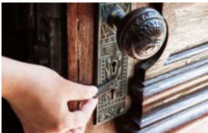
玄関扉の鍵には、泥棒除けのニセの鍵穴が。四角いフタを持ち上げると、下に本当の鍵穴が見れる仕組みになっている
