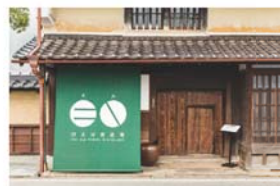
第100年越えの建物を可能な限りそのままにリノベート。蔵の真なる4室とそれを備えるホテルやレストラン等の複合施設に。
