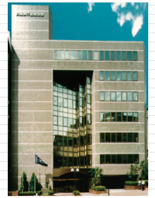
兵庫県不動産会館新築完成（平成4年6月）
