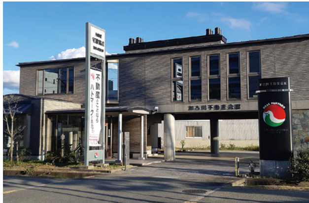
加古川不動産会館
