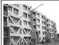
共同住宅 (外付けフレーム補強)
